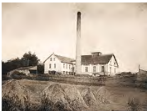
Takto vypadala Dynybylova továrna na pitelný líh v době svého vzniku. Byla na okraji Řičan.
